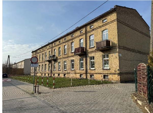
Zdjęcie 6. Jeden z budynków zabudowań pofabrycznych dawnej fabryki Moesa w Choroszczy – obecnie teren SSP ZOZ w Choroszczy.
